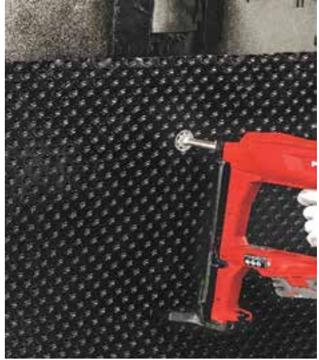
(d) Membrane fixing
